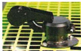
Silencieux d'échappement avec clapet anti-pluie
